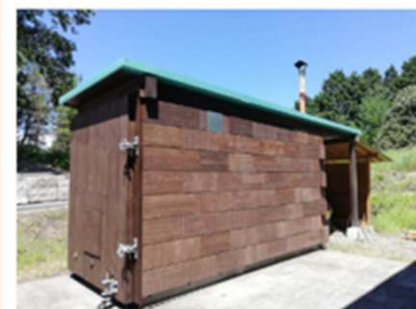
CLTブロックを活用した低環境負荷低温乾燥施設の開発
